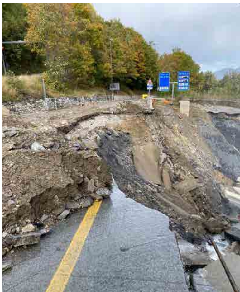
Figura 10 – Foto dei danni provocati da ALEX al sedime della strada statale e alle sue opere accessorie. Attualmente la tombinatura è stata demolita, mantenendo unicamente il tratto in attraversamento sottostante la strada militare. Tale attraversamento (Figura 11) è costituito da uno scatolare di larghezza pari a 2 metri circa, mentre la luce libera verticale residua risulta essere solo di 0,7 m in quanto la restante porzione è al momento ostruita da sedimenti depositati sul fondo dell'alveo.
