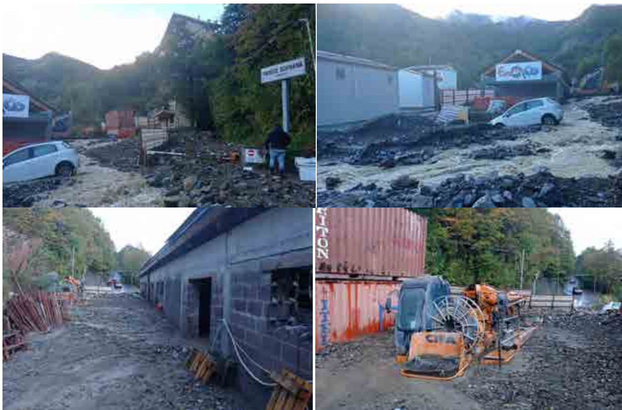
Figura 7 – Foto dell'affluente minore in prossimità del fabbricato impianti (foto del 3 – 4 ottobre 2020). L'intensità dell'evento ha generato fenomeni di dissesto oltre il fabbricato impianti, proseguendo sul sedime della S.S.20 e quindi sulla scarpata fino a confluire nel Rio Panice, (come sinteticamente schematizzato in Figura 8).
