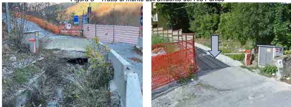
Figura 6 – Imbocco del tombino esistente visto da monte (sx); condizione antecedente l'evento Alex in cui l'intero tratto risultava tombato, vista da valle (dx) – la freccia indica la posizione del rio.
