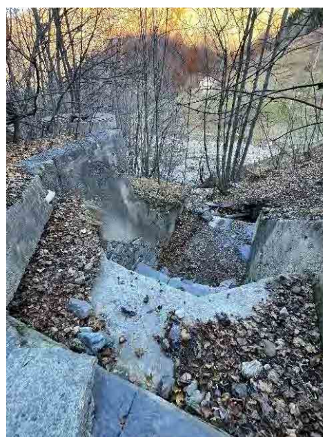
Figura 14 – Sbocco dell'attraversamento della S.S.20 sistemazione a salti di raccordo con l'alveo del rio Panice (dx)
