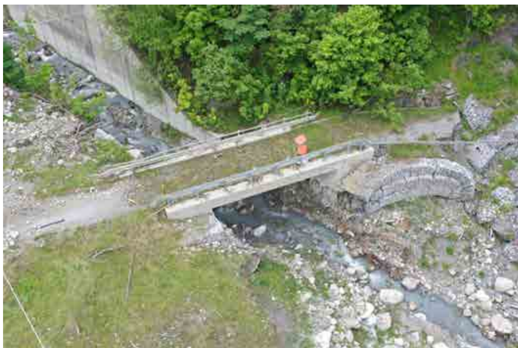
Figura 23 – Secondo attraversamento nella porzione di valle del tratto di studio Più a valle la sezione si allarga notevolmente verso destra, in quanto l'evento ha provocato l'erosione e arretramento di tale sponda fino in prossimità del piede del versante (Figura 24, Figura 25).
