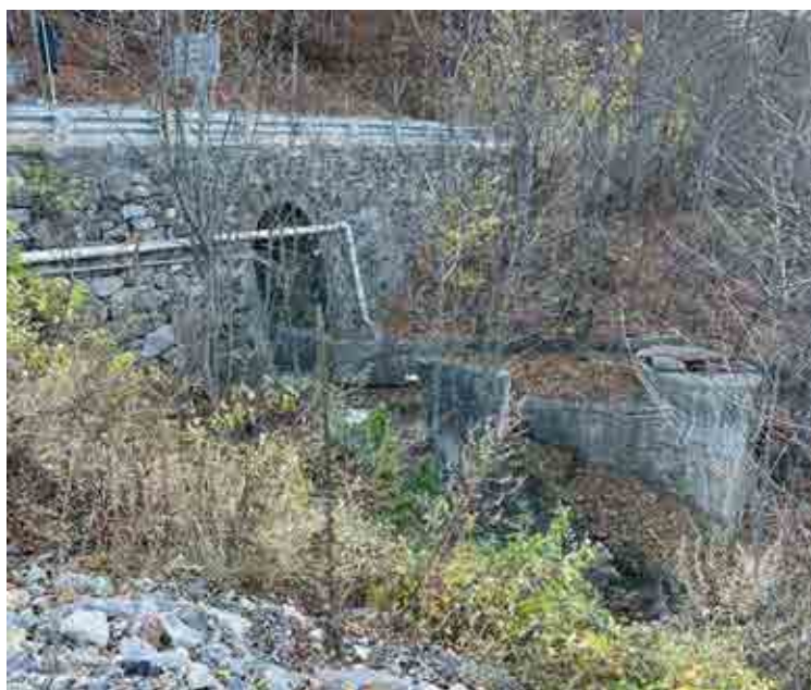
Figura 14 – Sbocco dell'attraversamento della S.S.20 sistemazione a salti di raccordo con l'alveo del rio Panice (dx)
