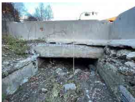
Figura 11 – Tratto tombato in corrispondenza dell'attraversamento, vista da monte (sx) e da valle (dx). A valle dell'attraversamento l'alveo prosegue, affiancandosi alla S.S.20, per una lunghezza di circa 40 metri, con pendenza media del 6%.
