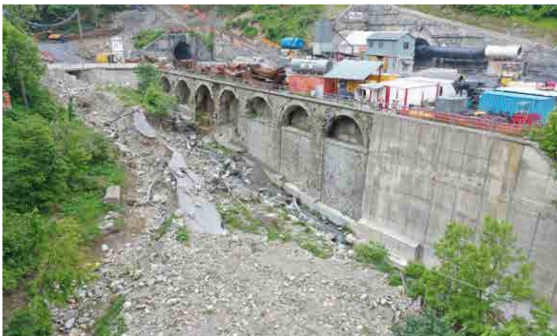
Figura 22 – Alveo a valle dell'attraversamento di monte, vista da valle verso monte In corrispondenza del termine del muraglione di sostegno del piazzale è presente il già citato ponticello di valle (Figura 23), più ampio del precedente, di luce pari a circa 3,5 m e larghezza pari a circa 7 m. Tale struttura risulta in discrete condizioni, e pare aver subito meno danni dalla piena, anche in relazione ai fenomeni già avvenuti a monte.
