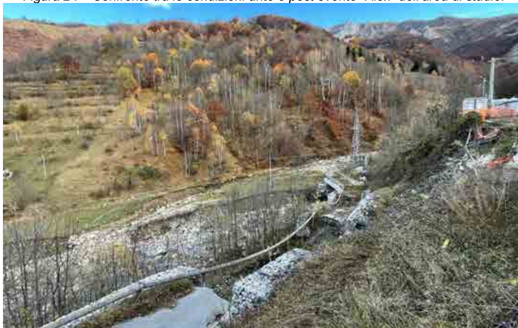
Figura 25 – Dissesti nel tratto di valle: alveo del Panice e (in primo piano) asportazione tratti della viabilità minore in sponda sinistra.
