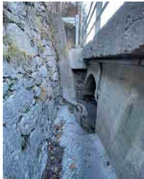
Figura 12 – Tratto in parallelismo alla S.S.20 (sx); immissione nell'attraversamento della Statale (dx). All'estremità di valle di questo tratto si ha una brusca immissione verso destra (con deviazione a 90°) all'interno di un attraversamento della Statale di dimensioni piuttosto ampie (Figura 12).
