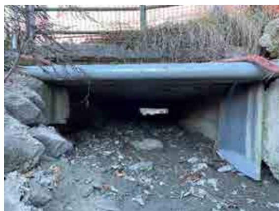
Figura 11 – Tratto tombato in corrispondenza dell'attraversamento, vista da monte (sx) e da valle (dx). A valle dell'attraversamento l'alveo prosegue, affiancandosi alla S.S.20, per una lunghezza di circa 40 metri, con pendenza media del 6%.
