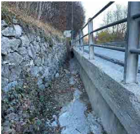
Figura 12 – Tratto in parallelismo alla S.S.20 (sx); immissione nell'attraversamento della Statale (dx). All'estremità di valle di questo tratto si ha una brusca immissione verso destra (con deviazione a 90°) all'interno di un attraversamento della Statale di dimensioni piuttosto ampie (Figura 12).
